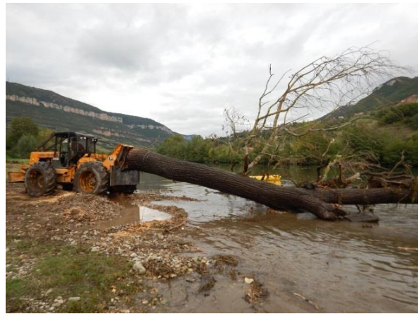
Treuillage à l'aide d'un débardeur forestier
