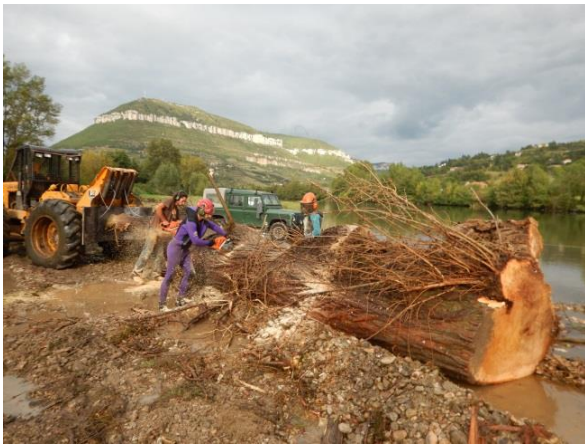
Tronçonnage d'un peuplier noir
