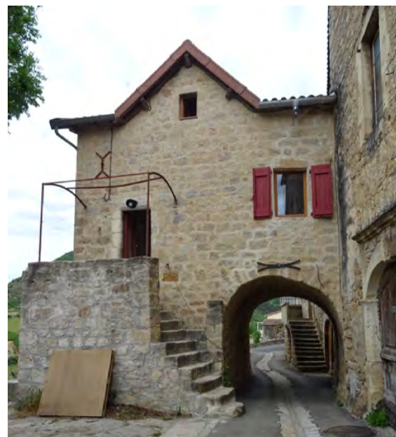
Fig. 73 - Joint à la chaux, teinte proche de celle de la pierre
