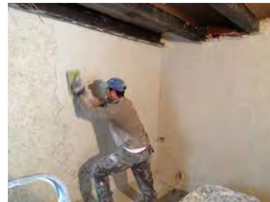
Fig. 83 - Finition chaux-chanvre
