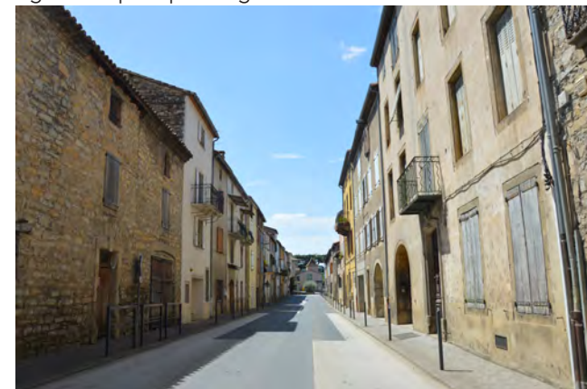
Fig. 10 - Rue principale - Saint George-de-Luzençon
