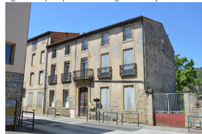
Fig. 12 - Rue principale - Saint George-de-Luzençon
