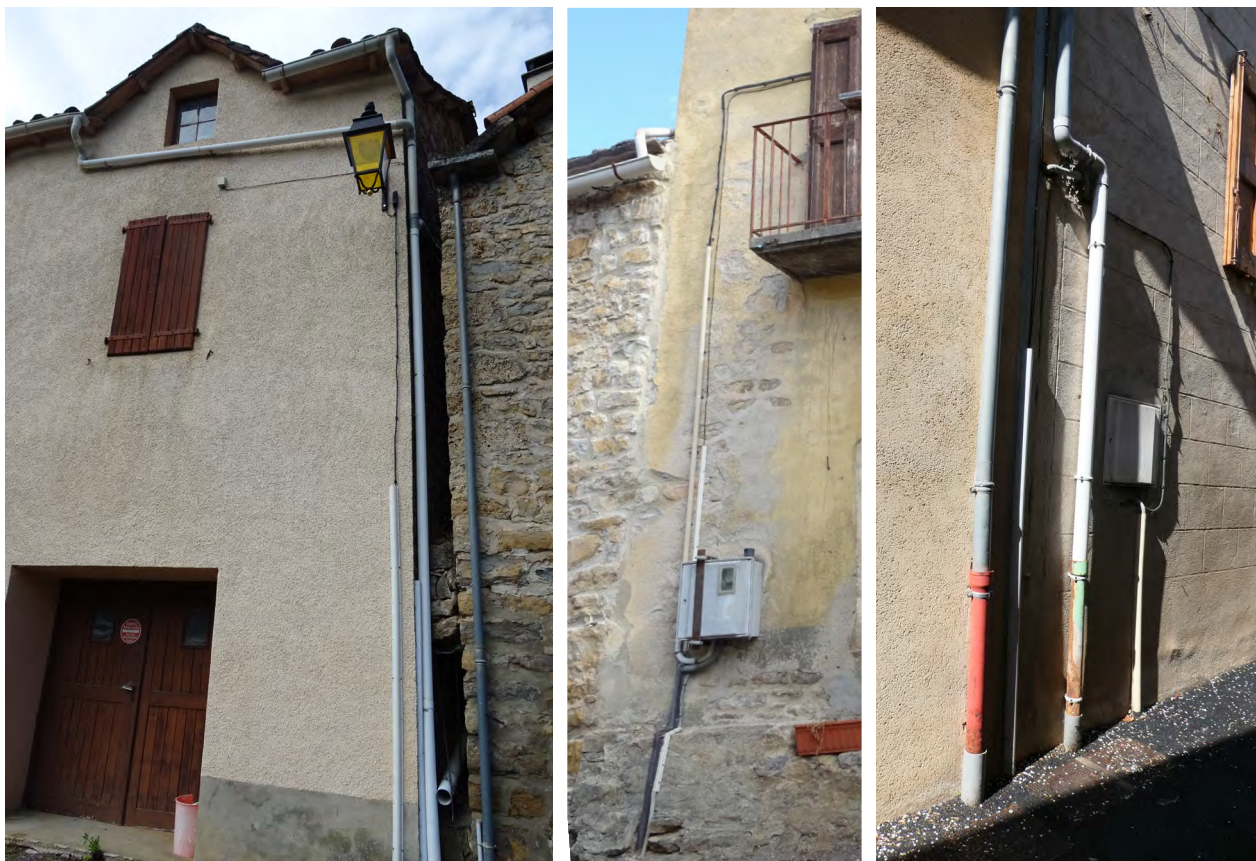
Fig. 87 à 89 - Réseaux et éléments techniques en façade
