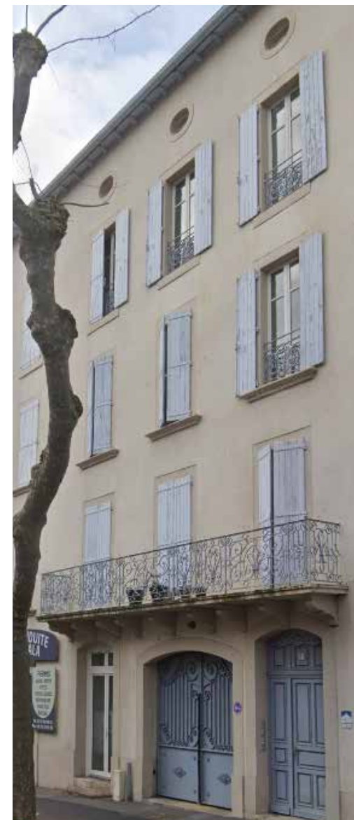
Fig. 44 - Éléments de second-œuvre restaurés
