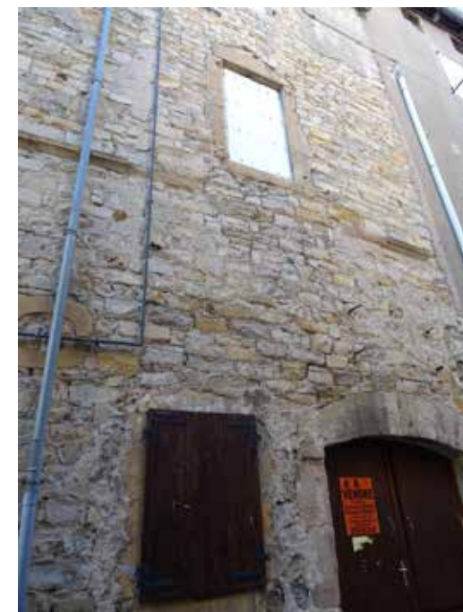
Fig. 60 à 63 - Retrait de l'enduit
