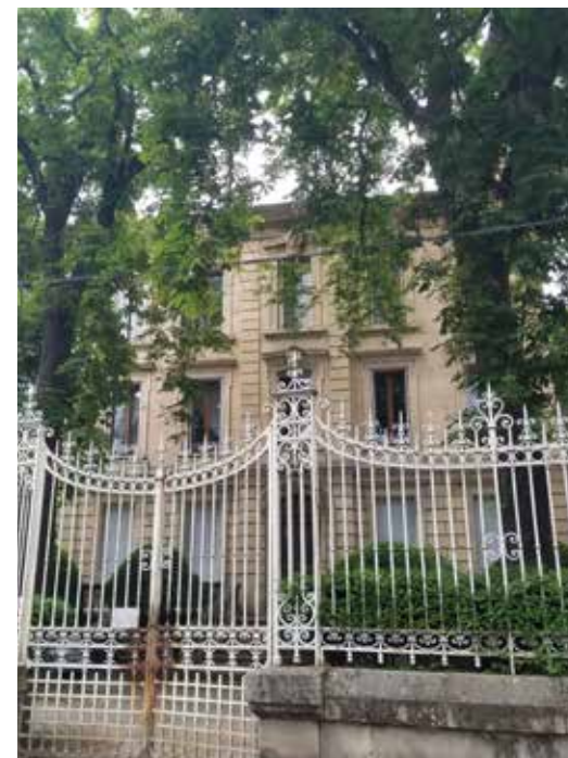
Fig. 31 - Maçonnerie en pierre de taille
