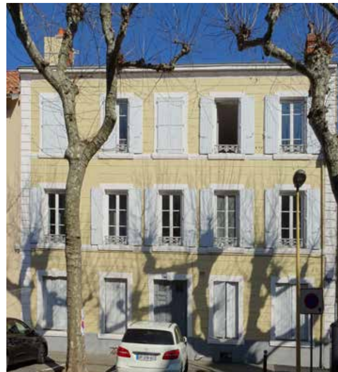
Fig. 34 à 36 - Finition d'enduit : évocation de la pierre de taille
