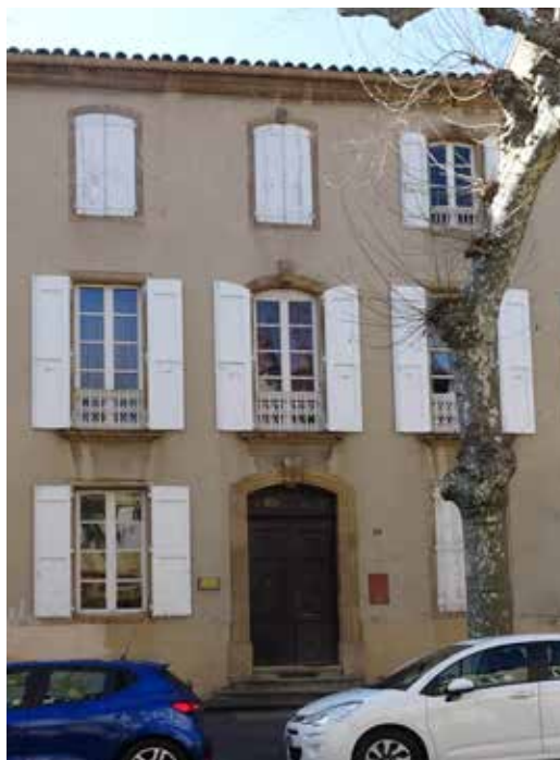
Fig. 30 - Maçonnerie en moellon enduit
