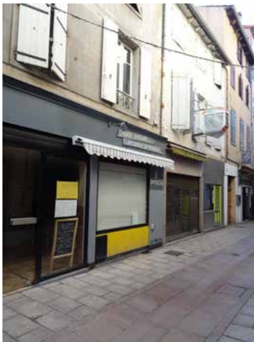
Fig. 77 - Juxtaposition de matériaux, couleur, dessin différents en rez-de-chaussée de chaque immeuble.
