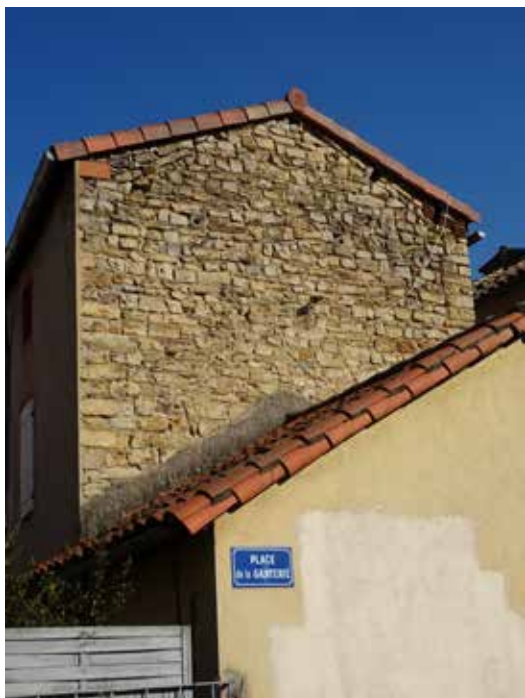
Fig. 29 - Maçonnerie en moellon
