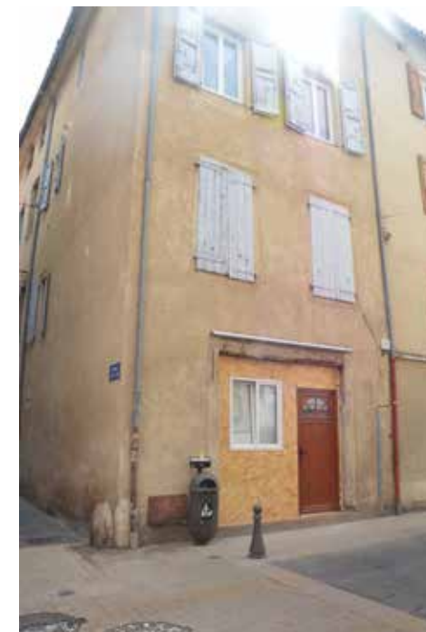
Fig. 76 - Une ouverture maladroite du rez de chaussée : perte de l'ordonnancement, juxtaposition de matériaux.
