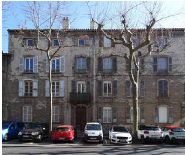
Fig. 14 - Immeuble de rapport
