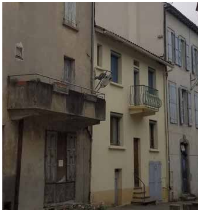
Fig. 75 - Dessin des balcons en rupture avec celui des ferronneries visibles à Millau.
