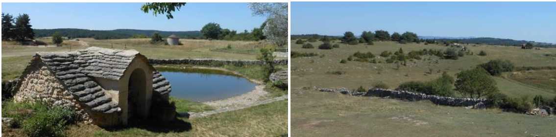
LAVOGNE ET CITERNE A VEYREAU, MURET A SAINT ANDRE DE VEZINES PHOTOGRAPHIES EVEN CONSEIL 2016 ©
