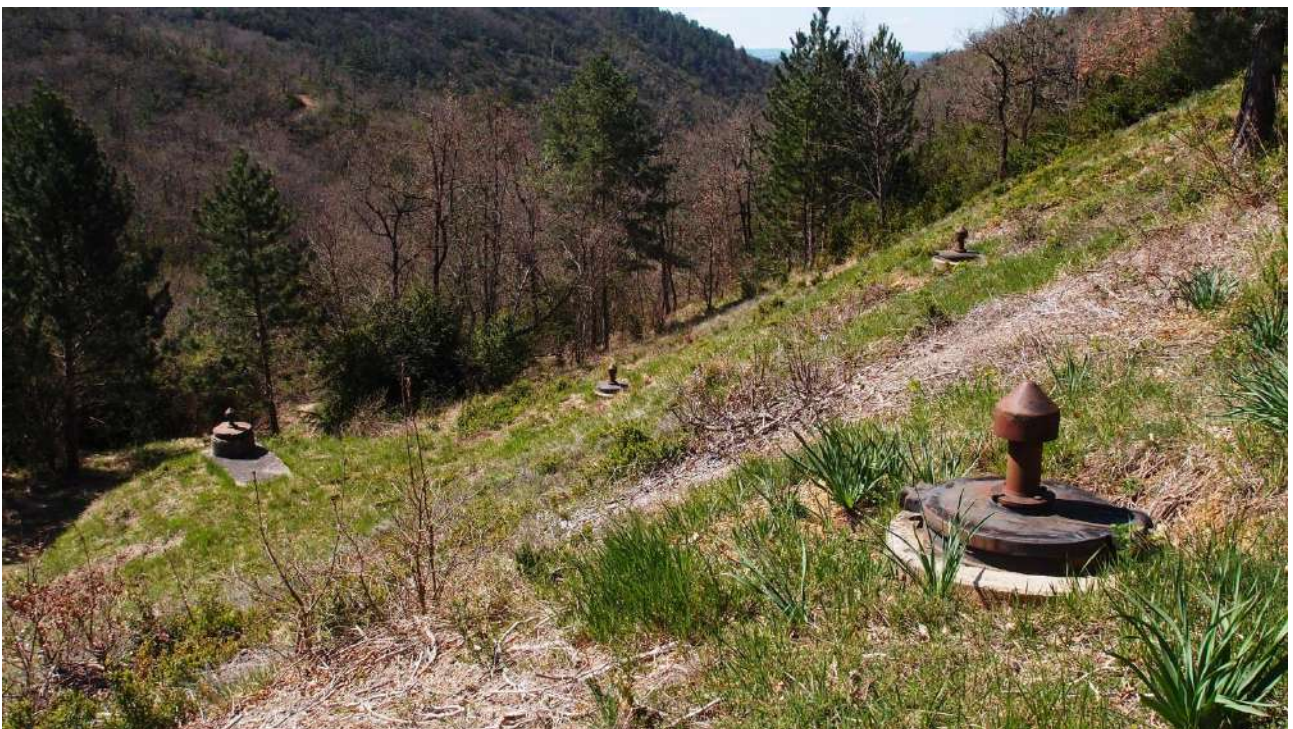
Photo 4 – Le captage des Balats, en bas à gauche le bassin collecteur
