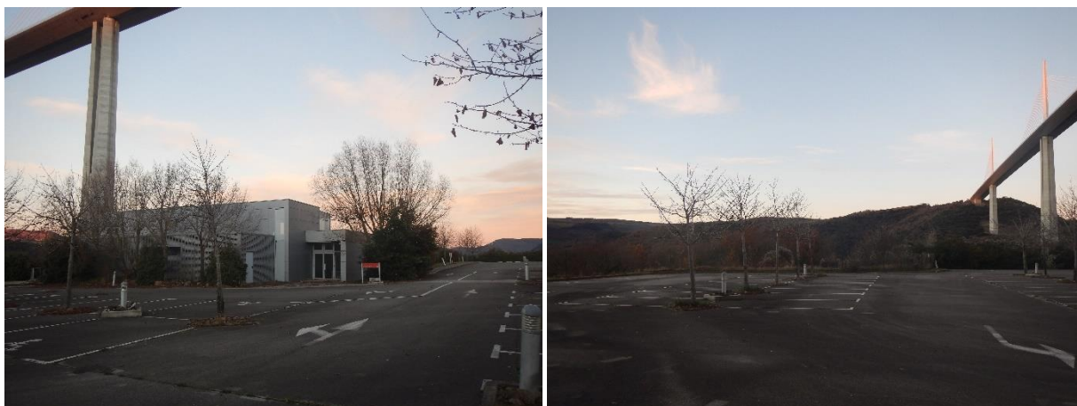
Photo 1 : Vue d'ensemble du secteur d'étude au pied du Viaduc de Millau, et présente de clôtures grillagées sur toute la périphérie (Citadia Conseil)
