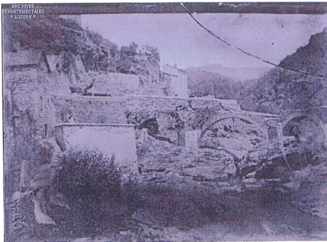
Pont de Vebron , le pont et le moulin après sa reconstruction. L 'habitation emportée se situait sur le moulin.(doc. photo plaque sur verre / Archives départementales de la Lozère.)
