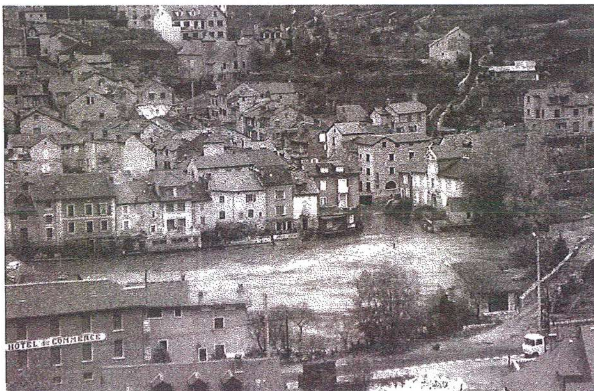
Sainte Enimie : Crue de 1982, depuis la rive gauche. ATTENTION : La photo n'a pas été prise au moment du « pic de crue ».
