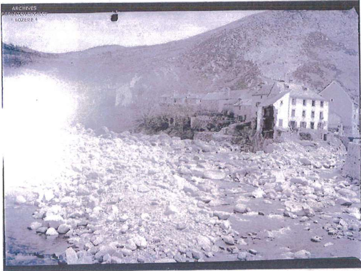
Le Pont de Monvert : vue depuis le pont., Maison éventrée, crue de 1900. (doc. Archives départementales de la Lozère)
