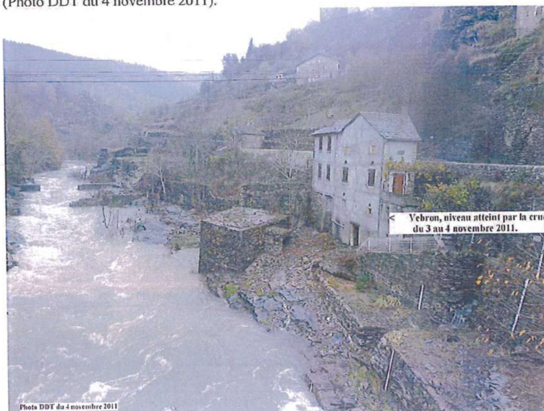
Ci-dessous, vue du pont, niveau atteint par la crue du 3 au 4 novembre 2011. (Photo DDT du 4 novembre 2011).
