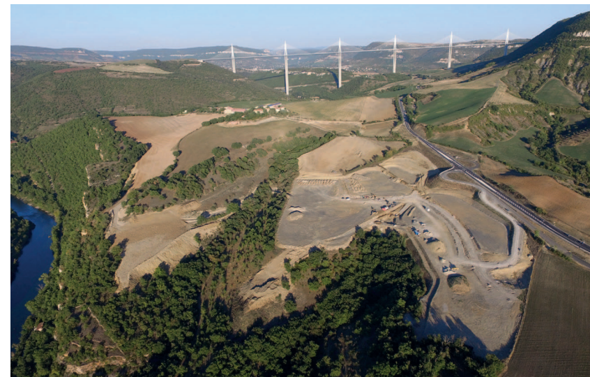
Millau Ouest en cours d'aménagement
