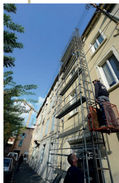
Embellissement de façade
