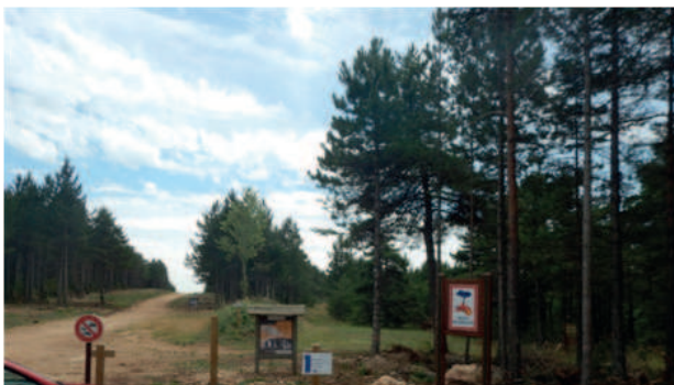
Travaux de protection sur le chemin de Boffi
