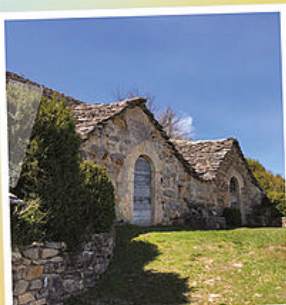
❶ RIVIÈRE-SUR-TARN Visite des caves d'Entre-deux-Monts
